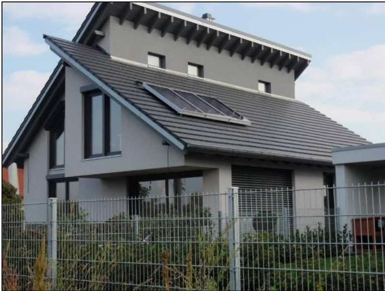
Wärmequelle: 3x Solarkollektor
